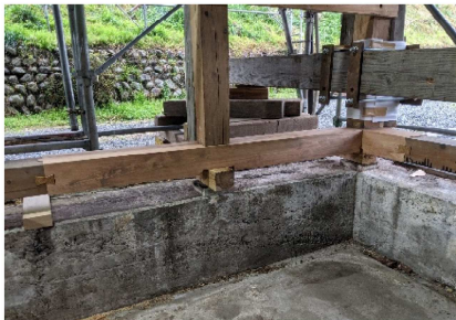
土台 継木補修
