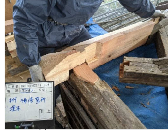
桁の腐朽部分の補修
