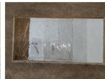
板蔵 塗り壁工程
