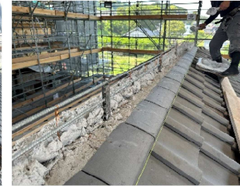
耐震棟の設置
