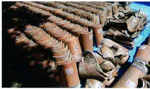
裏面に並べられた洋館の瓦(一枚ずつ番号を貼り、状態を調査している)
