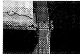
写真4 地震被害例 3) (B-1)
