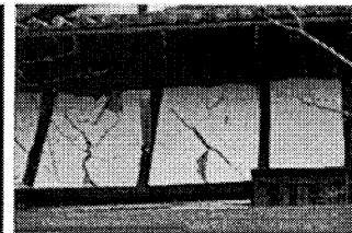
写真5 地震被害例 3) (土壁の亀裂)
