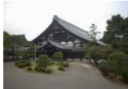
写真1 対象建築物の妻側外観
